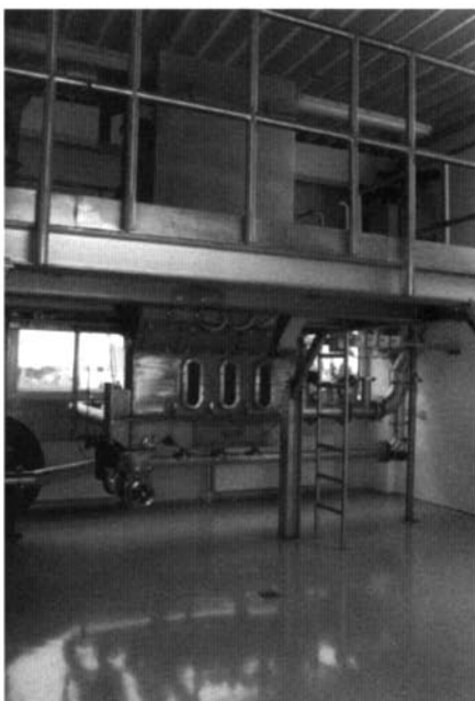
Photos Glatt Ingenieurtechnik GmbH
